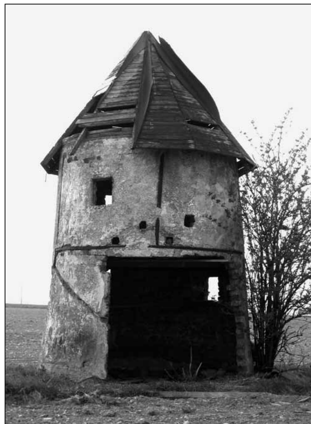
A jen pro připomenutí jak zbědovaně vypadal mlýn před začátkem oprav v roce 2004.
