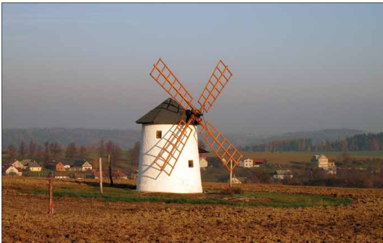
Opravený mlýn v roce 2012 dodaleka „svítí“ do krajiny.
