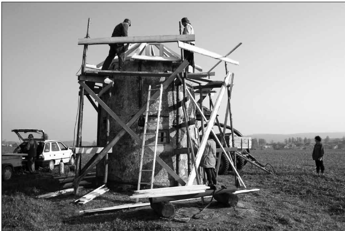
Výroba nové střechy v roce 2008.
